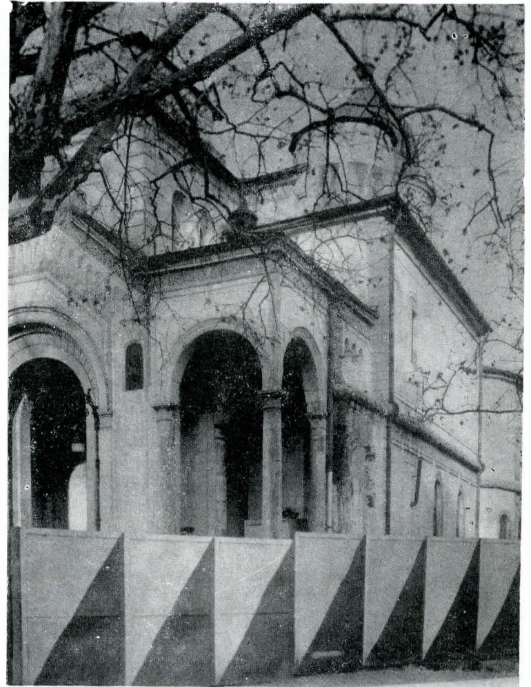
Fig. 11. Colțul de sud-vest (situația din 1976)
