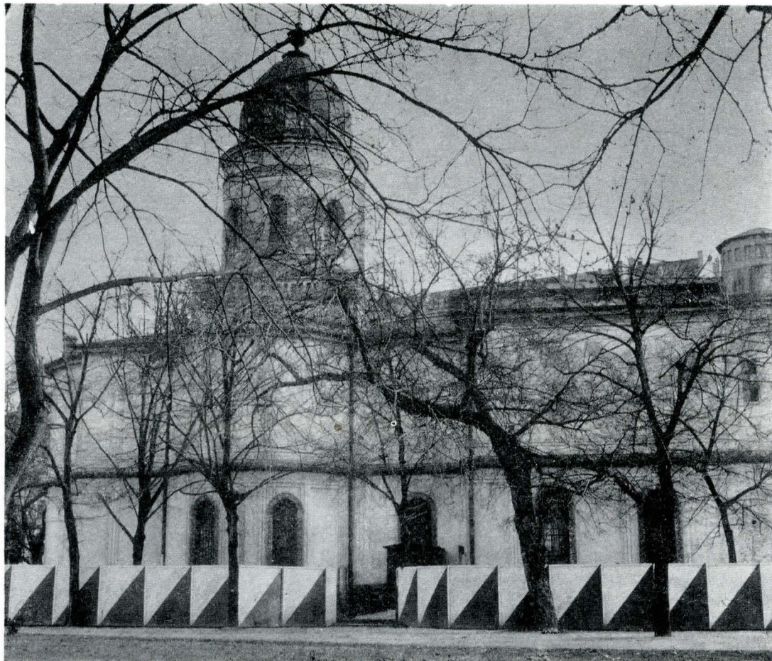
Fig. 12. Fațada nord (situația din 1976)
